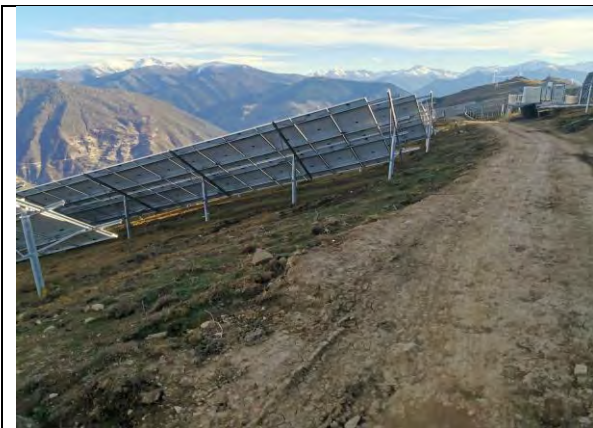
插图 4-17 道路工程区植被建设工程
