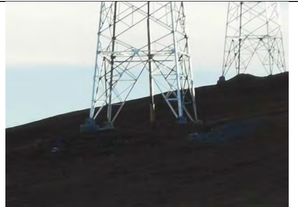
插图 4-16 输电线路工程区植被建设工程
