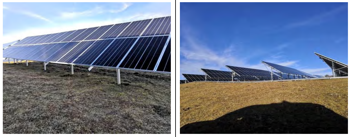
植被建设工程（光伏阵列工程区）
