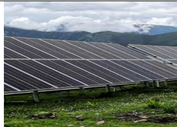
插图 4-14 光伏阵列区植被建设工程
