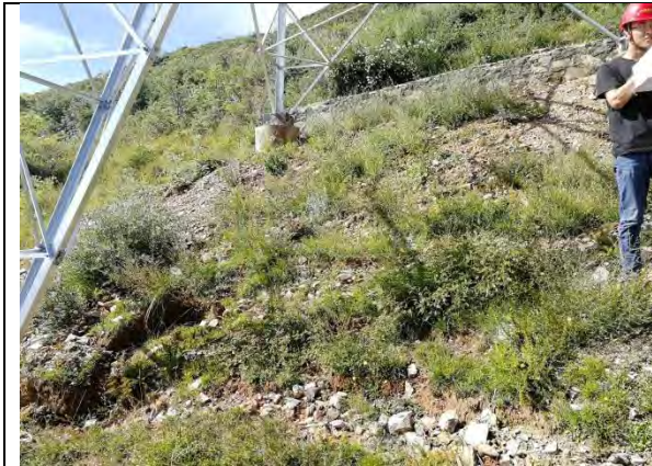
插图 3-19 施工临时设施区绿化
