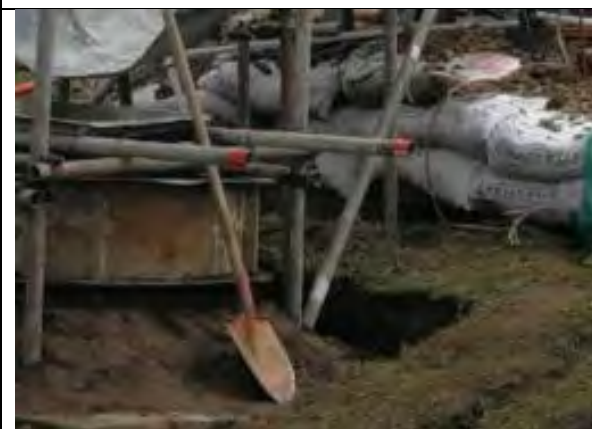
插图 3-11 输电线路土袋挡墙
