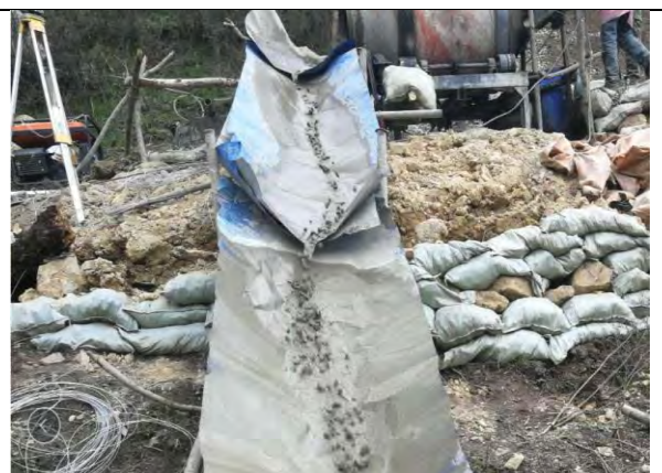
插图 3-12 输电线路土袋挡墙
