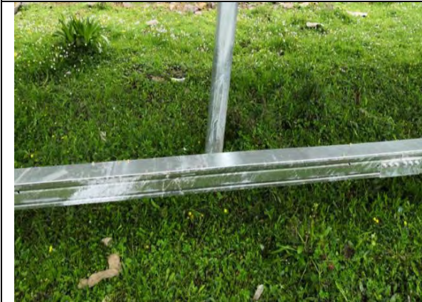
插图 4-11 光伏阵列区植被建设工程
