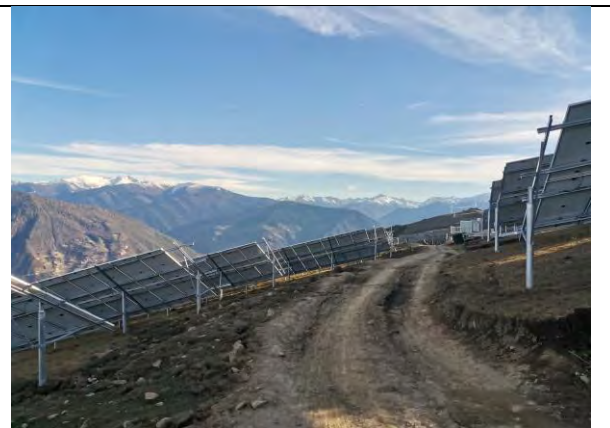
插图 4-18 道路工程区植被建设工程
