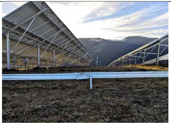
插图 3-4 集电线路槽绿化
