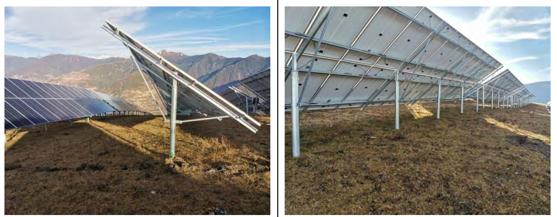
植被建设工程（光伏阵列工程区）
