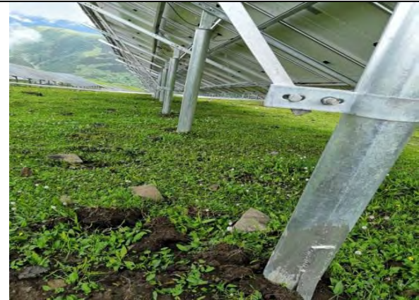
插图 4-12 光伏阵列区植被建设工程
