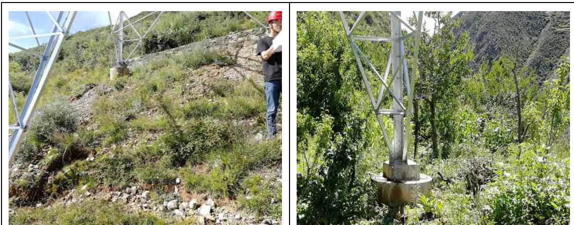
植被建设工程（输电线路工程区塔基）
