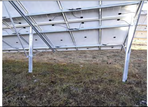
插图 4-10 光伏阵列区植被建设工程
