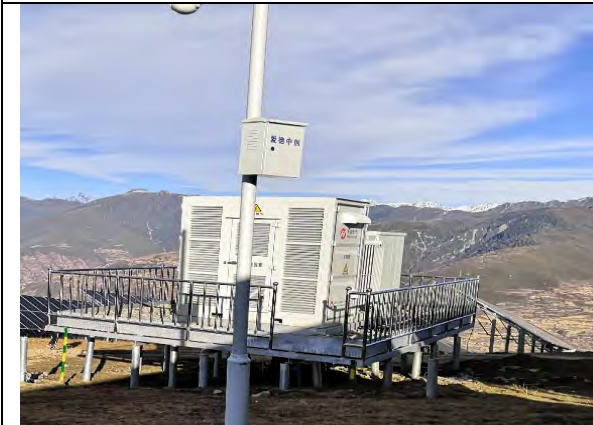
插图 4-13 光伏阵列区植被建设工程
