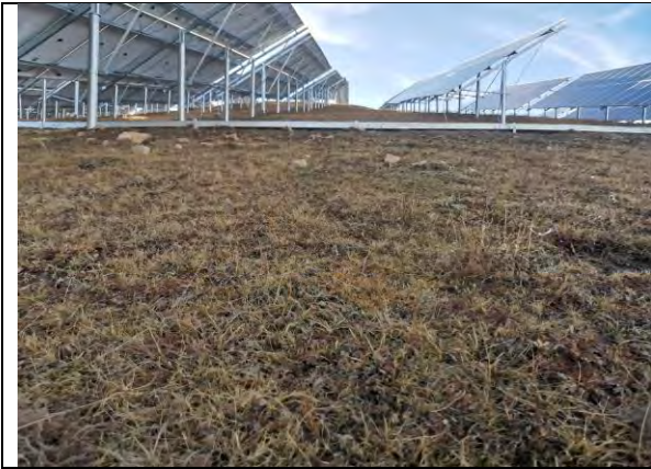
插图 4-9 光伏阵列区植被建设工程
