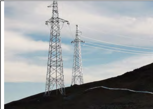
插图 4-15 输电线路工程区植被建设工程
