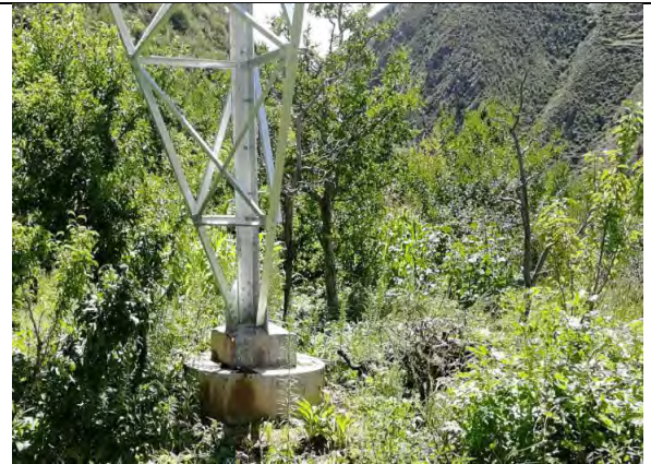
插图 3-20 施工临时设施区绿化(塔基周围)
